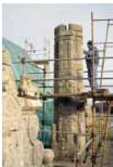
Travaux à l'abbaye de Beauport © Bardel / Conservatoire du littoral
