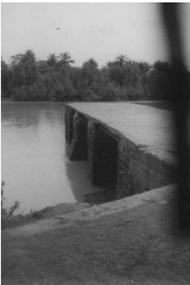
Bridge, trace of the slave trade, Rio Nunez Pont, vestige de la traite négrière, Rio Nunez
