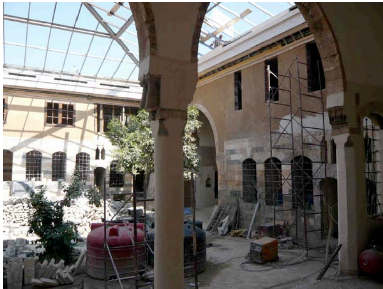
Figure 5 – Transformation d'une maison en hôtel, Beit Farhi .
