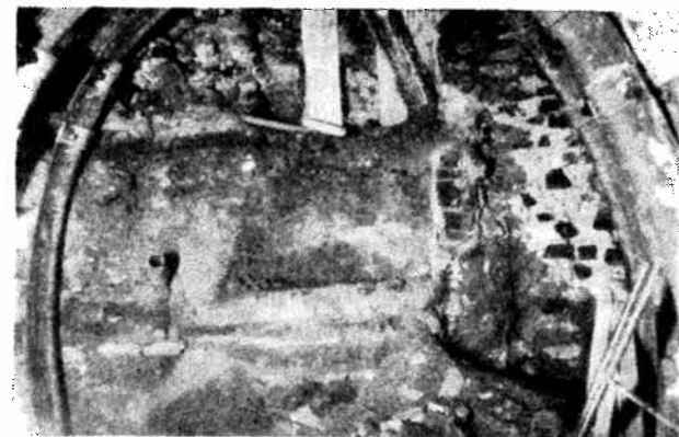
Fig. 2. Cette photographie du front du couloir percé dans le sous-sol de la rue Myslíkova en direction du carrefour „U Mánesa“ (Prague 2e), a été prise au commencement des recherches non destructives. Dans la partie droite de la photo, le couloir traverse la maçonnerie d'un édifice alors inconnu, la partie médiane de l'étage montre le niveau de l'ancien trottoir ainsi que le remblai d'argile contenant des condres et des restes d'une conduite de distribution de gaz; dans la partie supérieure, remblai composé de matériaux provenant probablement de la démolition des parties supérieures de l'édifice
