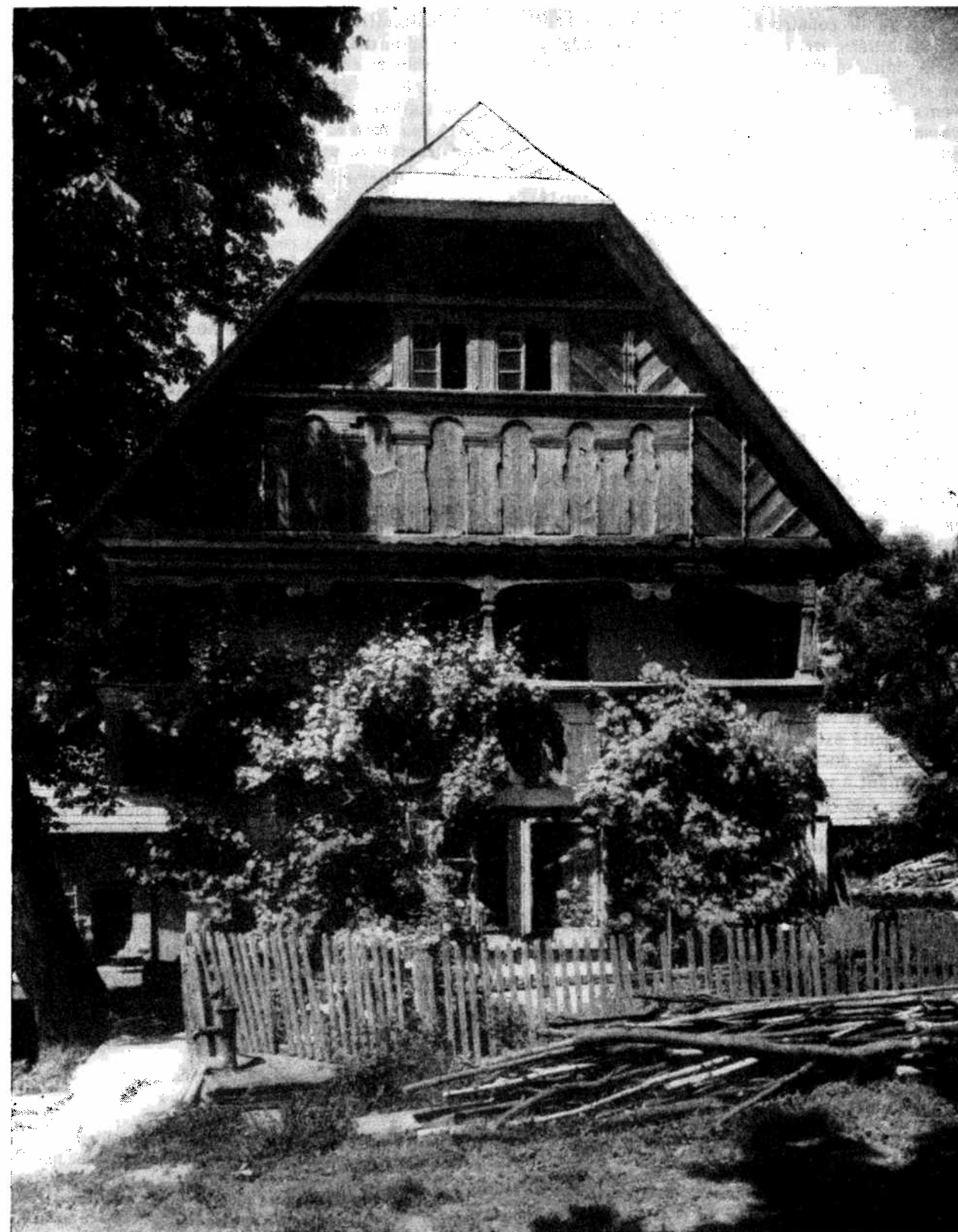
[5] Hameau Spáence n° 1, commune Markvartice. Ouvrage d'architecture folklorique très précieux de l'époque culminante de l'évolution de la maison de la Bohême orientale. La documentation a été établie en 1962 par la
