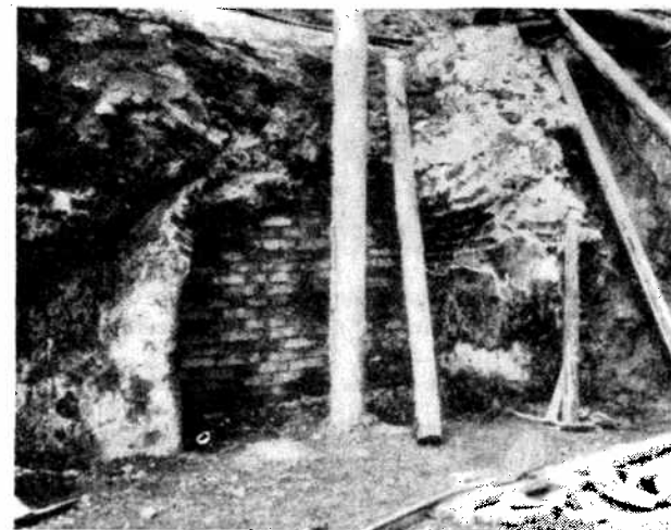
Fig. 4b. Vue d'une partie des voûtes au-dessous du trottoir; lors de l'assainissement des parois de l'excavation dans l'espace de l'anomalie, ces voûtes ont été renforcées de soubassements
