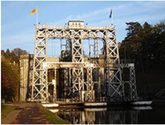
Elevador Núm. 2, Los cuatro elevadores del Canal du Centre (Uso de la fotografía autorizado por Wikimedia Commons)
